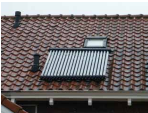
Afb. 4.17 Zonneboiler met vacuümbuizen (links) en vlakke plaat collectoren (rechts)
