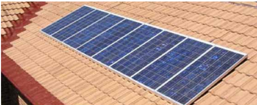
Afb. 4.18 PV-panelen met afmeting van ongeveer 1,65x1,0 meter komt overeen met 4,5 pan hoog, 4 pannen breed per paneel
