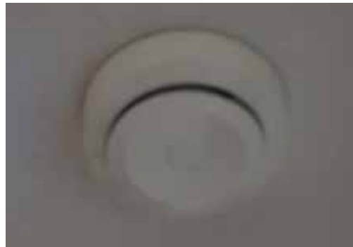
Afb. 4.16 Toevoerrooster ventilatielucht, te herkennen door opstaande rand en het uitstekende plaatje waardoor de luchtverspreiding in de ruimte wordt bevorderd
