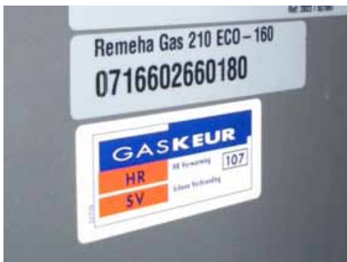
Afb. 4.8 CV-ketel met HR-keur (HR107) (links) en HR107 combiketel (rechts)
