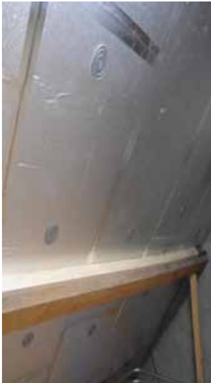
Afb.4.6 Isolatie op vliering tussen de gordingen
