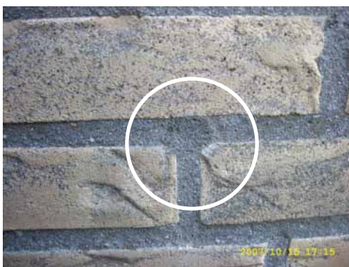
Afb. 4.3 Boorgat in de gevel
