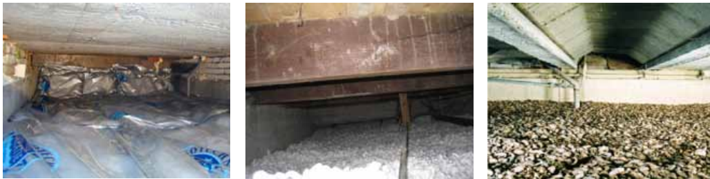
Afb. 4.7 Na-isolatie in de kruipruimte, met respectievelijk isolatiedekens, parels en schelpen
