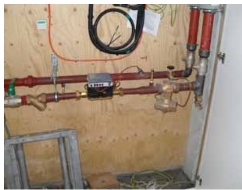
Afb. 4.11. Secundaire stadsverwarmingsaansluiting (alleen CV)
