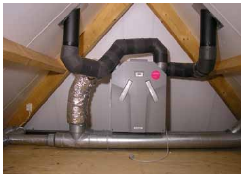
Afb. 4.14 Ventilatie-unit voor mechanische toe- en afvoer van lucht (gebalanceerd ventilatiesysteem)
