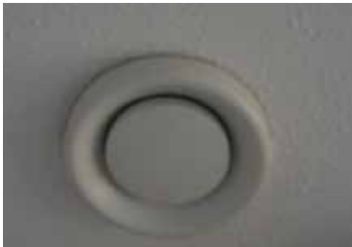
Afb. 4.15 Afvoerrooster ventilatielucht
