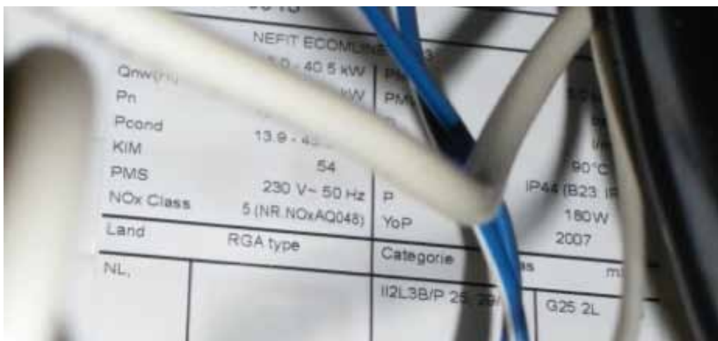
Afb. 4.9 Typeplaatje CV-ketel met bouwjaar 2007 (YoP = Year of Production)
